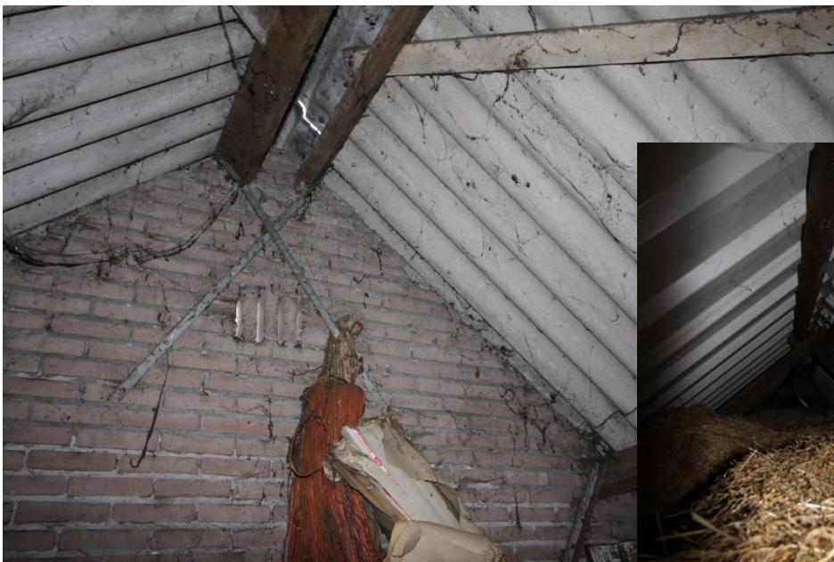
Dakconstructie van het schuurtje met hooiopslag
