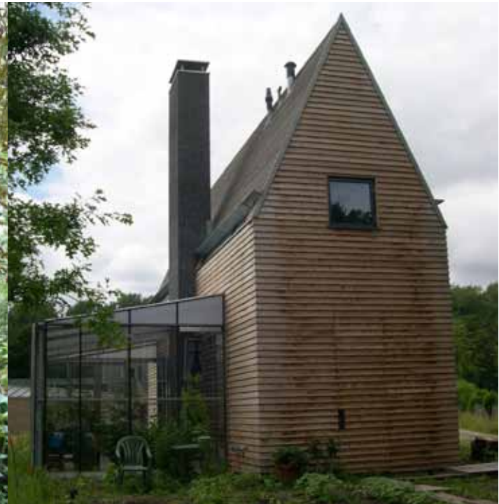
eigentijdse houtbouw op Fort Blauwkapel
