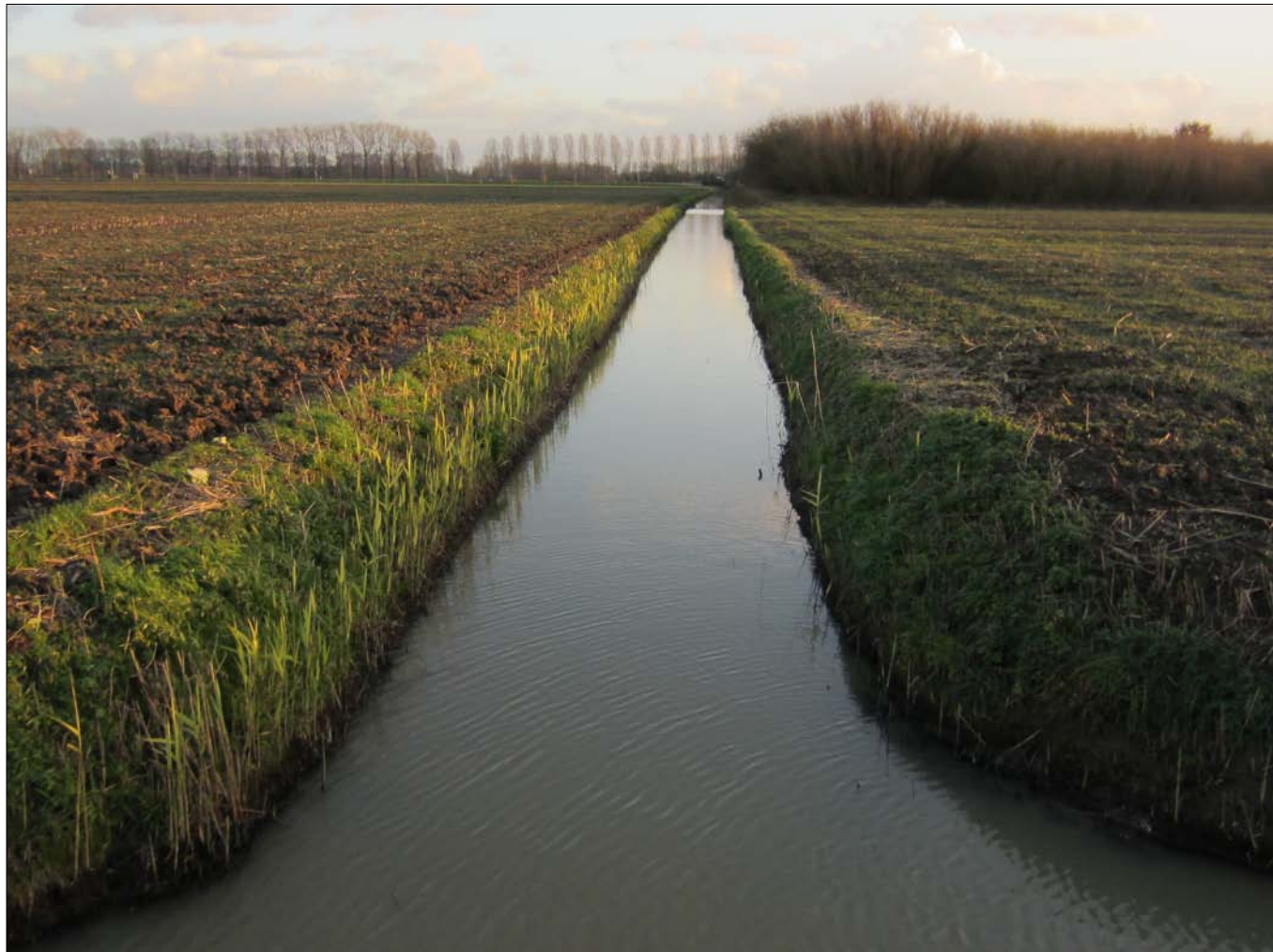
A-watgang: richting gemaal Panoven en het Merwedekanaal. Let op de steile oevers met rietscheuten.
