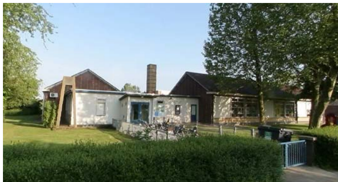
Kleinschalige bebouwing De Brug, gelegen aan het Zwanengat
