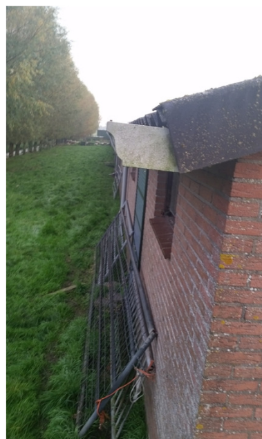
de brede dakgoot
