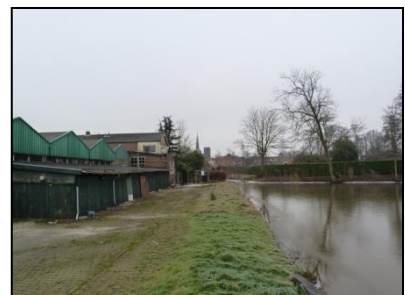
Figuur 8. Terrein achter de showroom.
