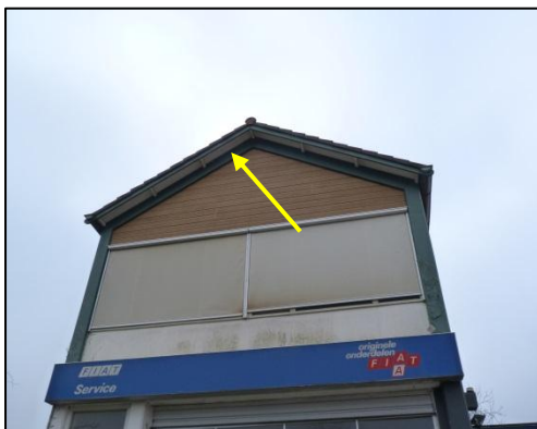
Figuur 11. Geschiedte openingen langs dakrand.
