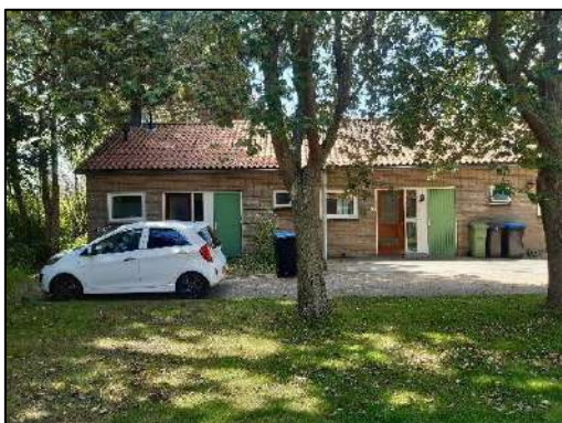
Foto 1: woningen aan de Patrijzenlaan
