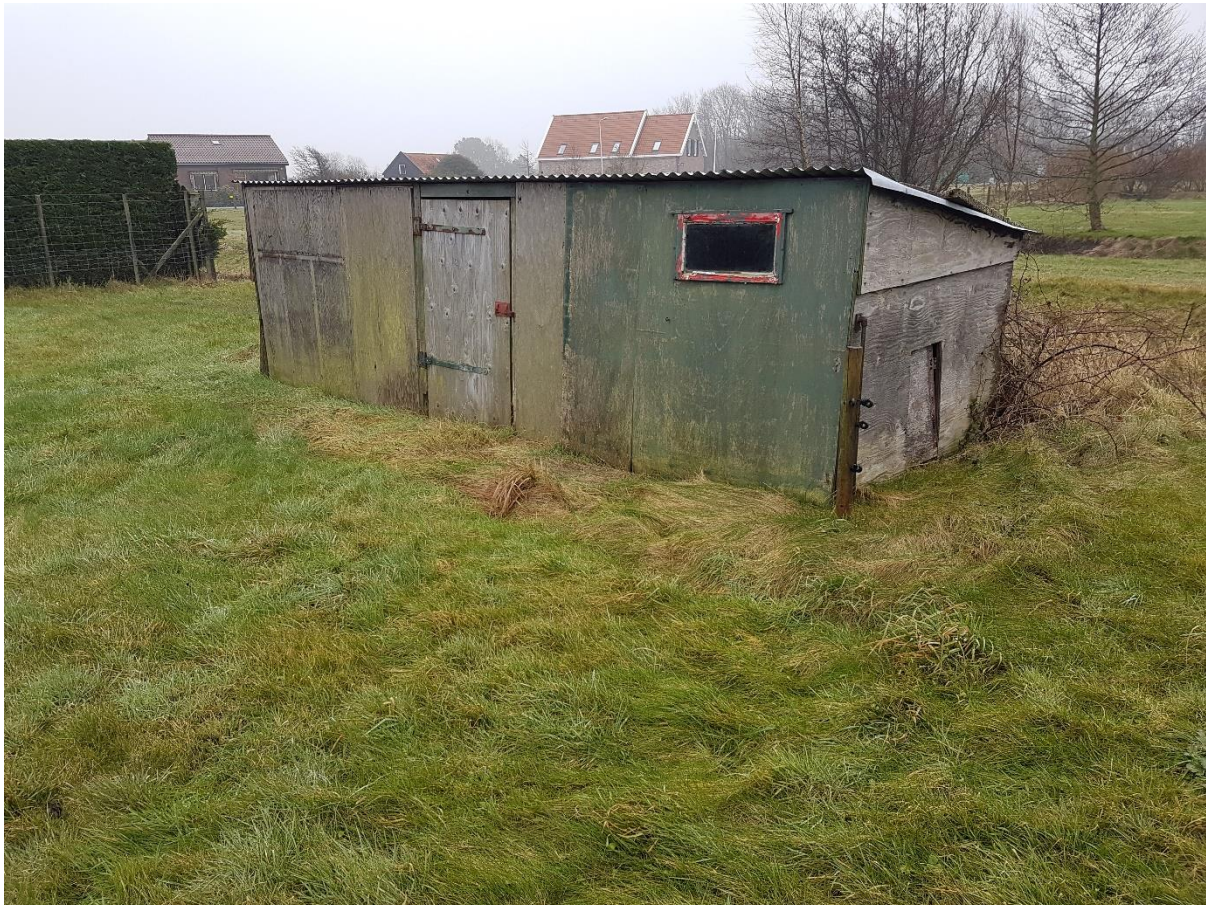
Onderzoekslocatie, oostzijde, perceel 1682, (schapen)hok, kijkrichting zuidoost
