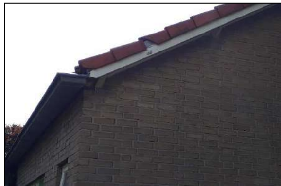
Foto 2: kapotte kantpan die kan dienen als invliegopening voor vogels en vleermuizen.
