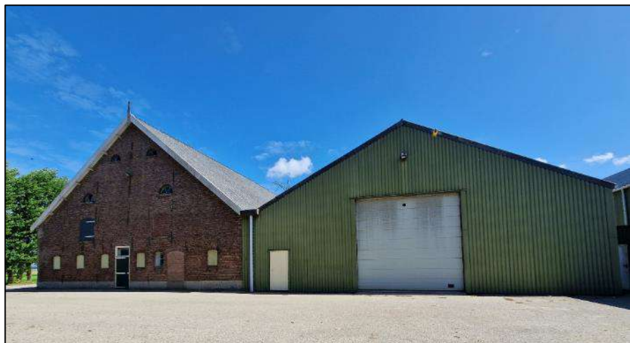
Oude schuur (links) valt buiten het plangebied. Deze schuur grenst direct aan een nieuwe schuur (rechts) die wel in het plangebied ligt. In de oude schuur is een nestkast die bewoond is door kerkuil.
