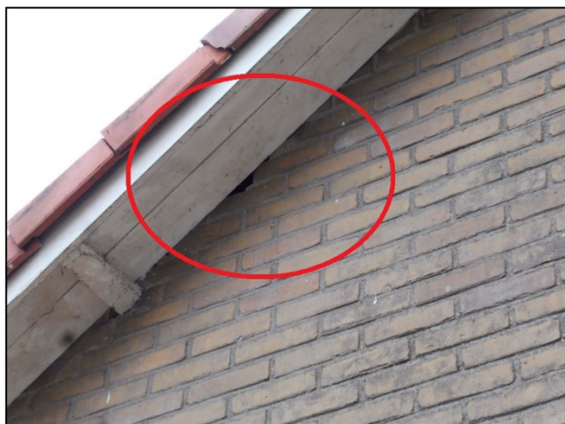
Foto 1: Gat met toegang tot spouwmuur in de westgevel van het voormalige verenigingsgebouw
