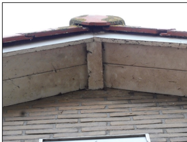
Foto 2: Kantpannen en nokpan met ruimte voor vleermuizen/gierzwaluwen
