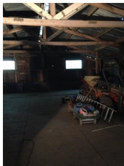
Foto 2: Bedrijfsgebouw met betonvloer en bestrijdingsmiddelenkast
