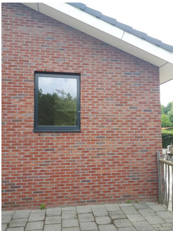
Gevel aan de noordkant van de bebouwing met daarin open stootvoegen. Foto: J. Keyzer / Ecoresult B.V.
