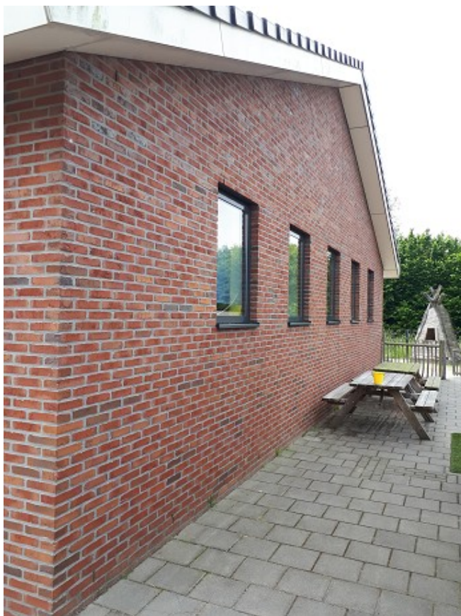
Gevel aan de noordzijde van het plangebied waar de uitbreiding van de bebouwing plaats gaat vinden. Foto: J. Keyzer | Ecoresult B.V.
