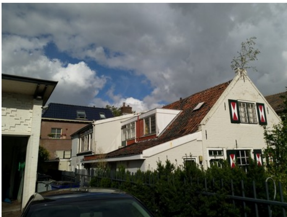
Zuidoost kant van het woonhuis. (Foto: V. Stuit | Ecoresult B.V.).
