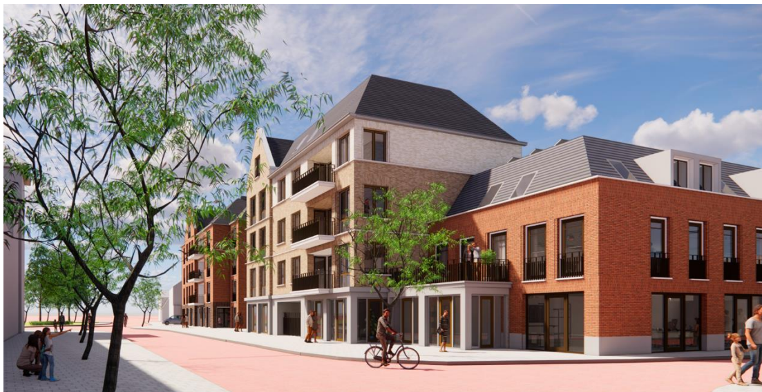
Afbeelding: aanzicht aangepaste hoek Dorpsdijk/Werkersdijk
