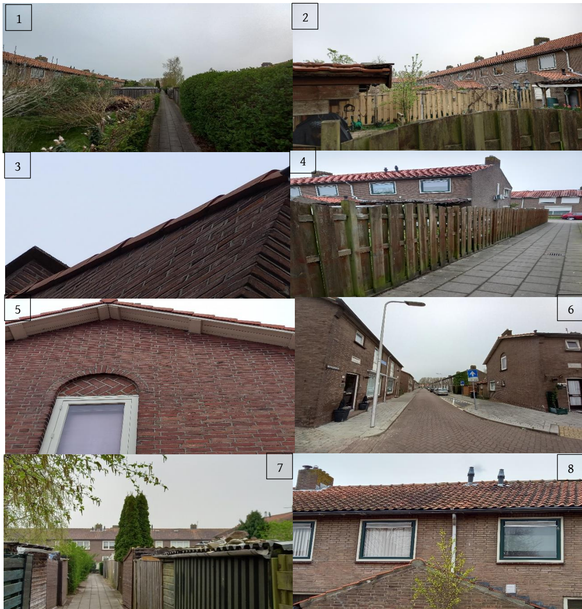
Figuur 3.2: Foto impressie plangebied. 1. Impressie groene tuinen binnen het plangebied 2. Impressie tuinen binnen het plangebied 3. Overhangende dakpannen kopse gevels 4. Versteende delen binnen het plangebied 5. Overhangende dakpannen plangebied 6. Impressie straatbeeld plangebied 7. Impressie paden plangebied met aangrenzend de tuinen 8. Impressie aanwezige daken binnen het plangebied.
