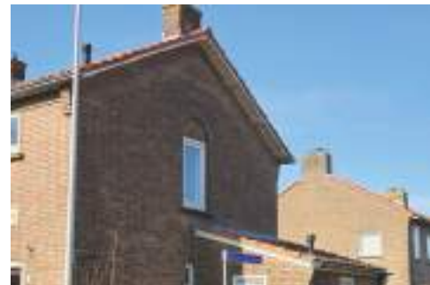
Ramen in de kopgevels
