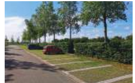
waterdoorlatende verharding parkeerplaatsen
