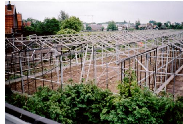
Afbeelding 3: De kas in aanbouw
