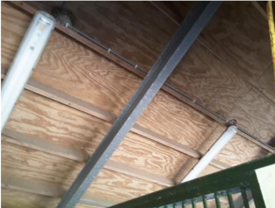
binnenzijde dak schuur
