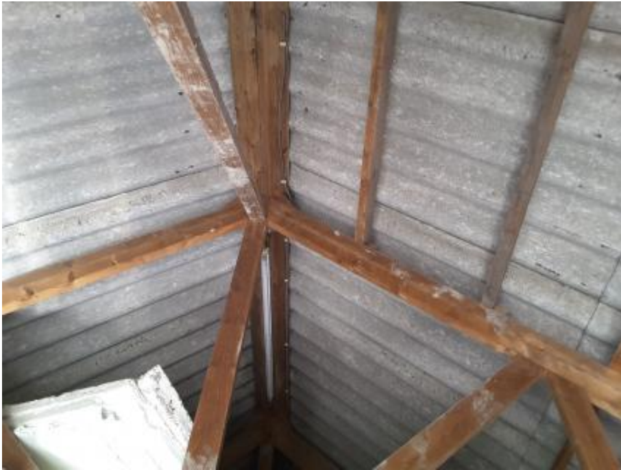
binnenzijde dak garage
