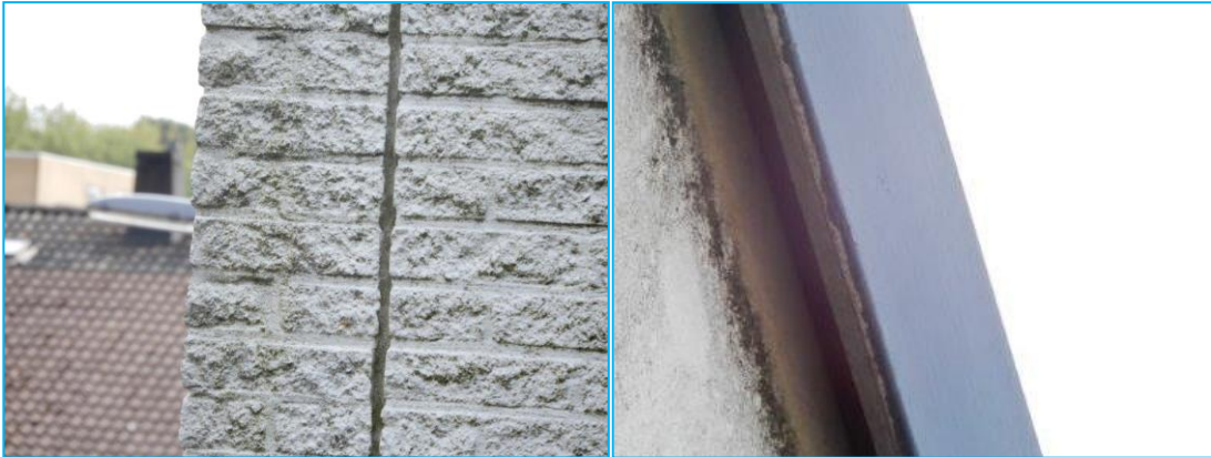
Foto's: Openingen die vanaf de grond in potentie toegang leken te geven tot de spouw blijken bij nader onderzoek toch geen toegang te geven.
