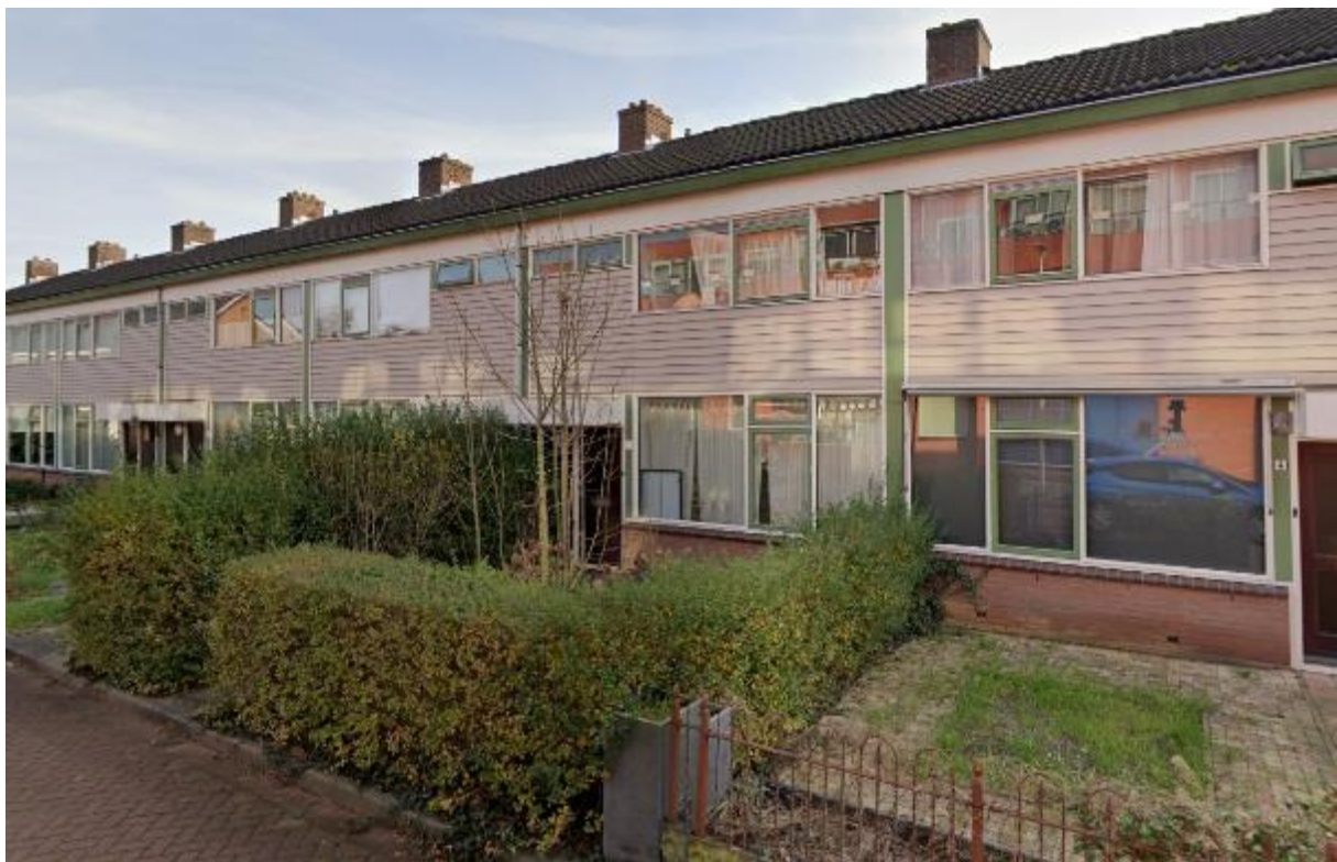
Figuur 2.1 Impressie huidige situatie (bron: Google Streetview)
