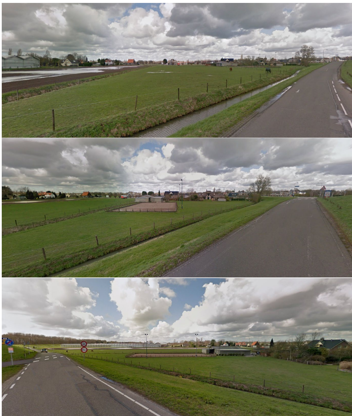
Overzichtsfoto's bestaande situatie (bron: maps.google.com)
