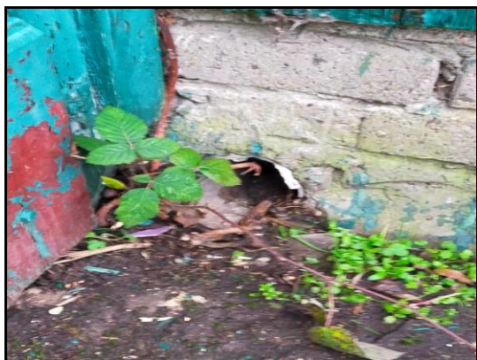
Afbeelding 10: Opening in gevel naar achterliggende ruimte
