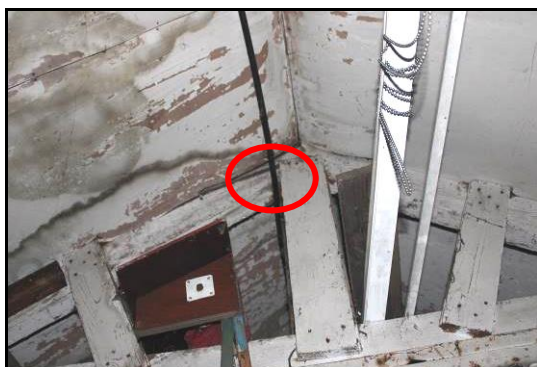
Afbeelding 8: Inpandig ruimte achter houten beplating
