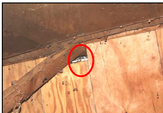
Afbeelding 7: Inpandig ruimte achter houten beplating
