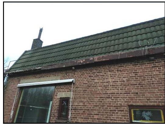
Afbeelding 15: Ruimte onder dakpannen
