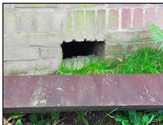
Afbeelding 13: Toegang tot kruipruimte woonhuis
