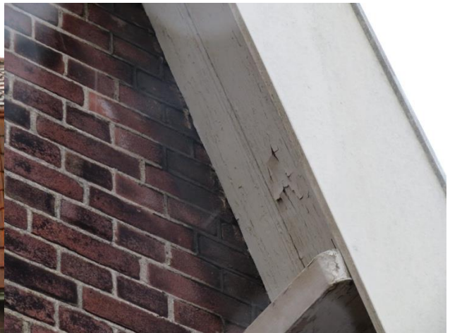
Afbeelding 5: de dakoverstek sluit goed aan op de gevel
