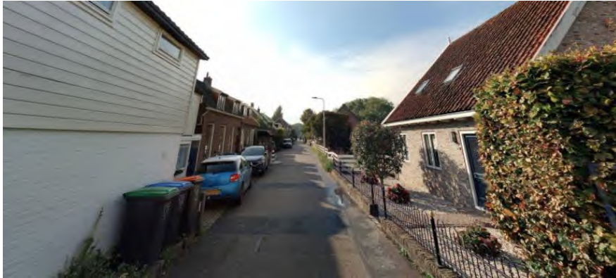
Figuur 3.6 - Impressie van de Welhoeksedijk
