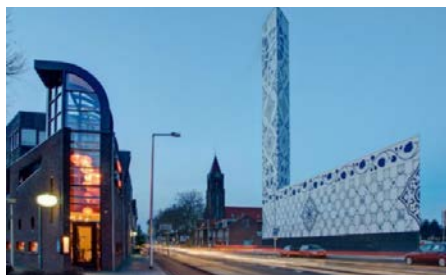
Voorbeeld centrale warmtepomp in Enschede
