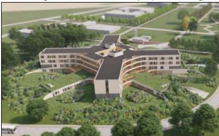
Figuur 6: Nieuwbouw kliniek J (bron: NvU, Wissing)
