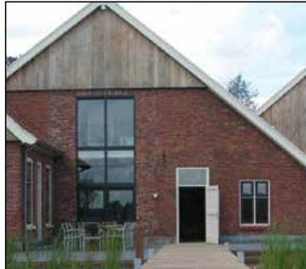
architect: SchipperDouwes Architectuur, Wierden
