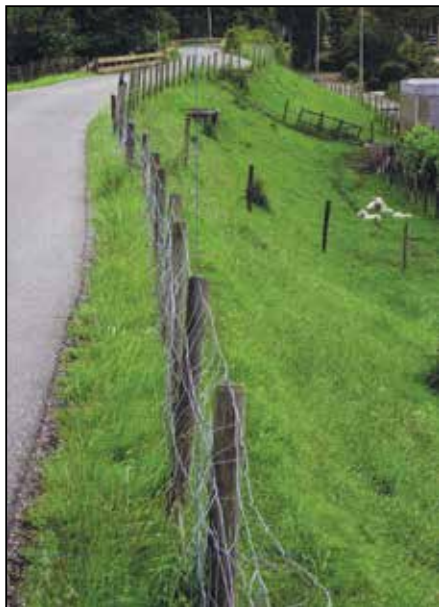
Erfscheiding bovenaan de dijk open, laag en landelijk.
