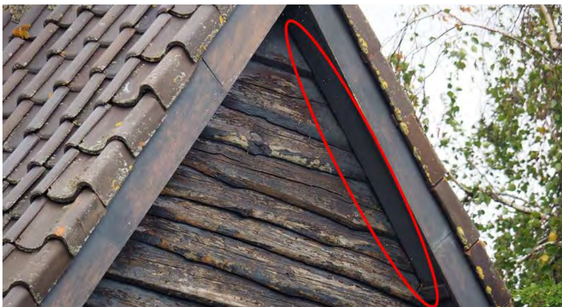
Figuur 9: Geschikte openingen voor vleermuizen.
