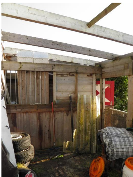
Figuur 7. Binnenzijde van de voormalige paardenstallen.
