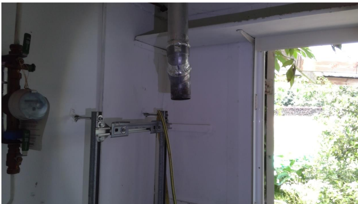
Foto F07 Plaatmateriaal type 1 Binnenzijde woning
