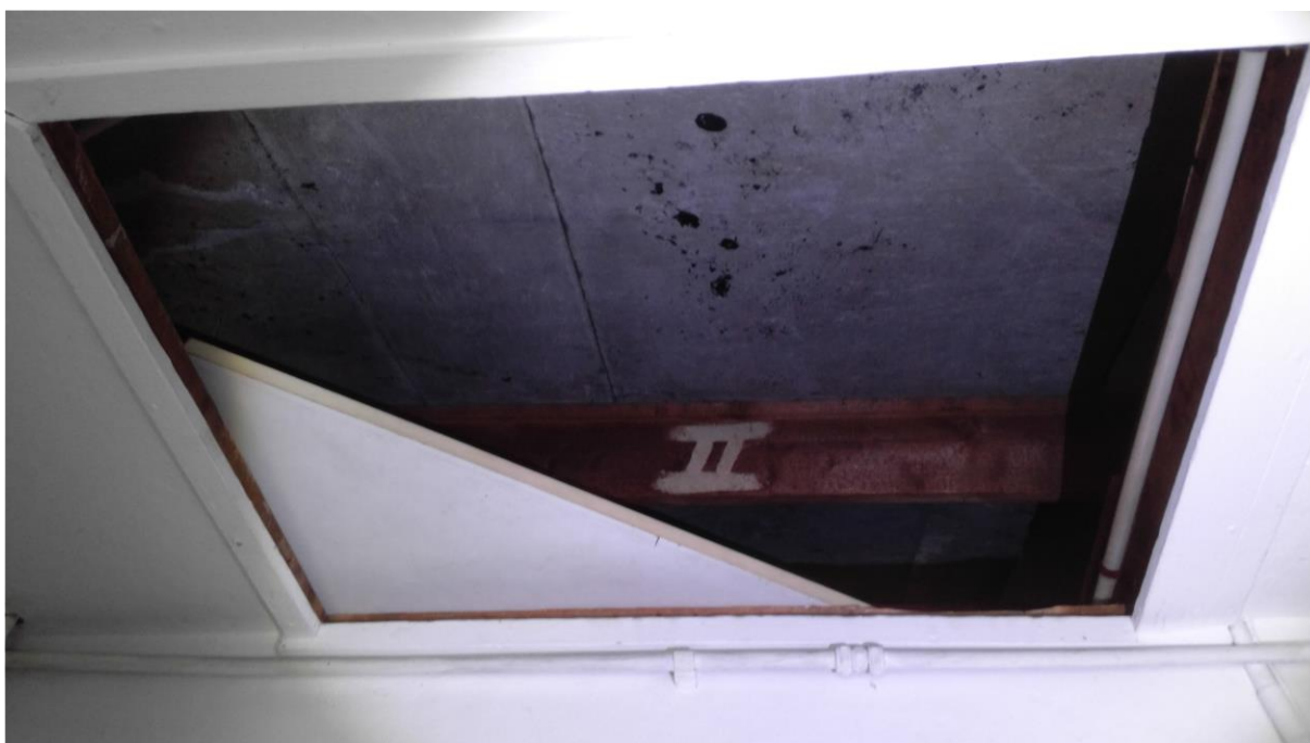
Foto F20 Plaatmateriaal type 1 Zolder
