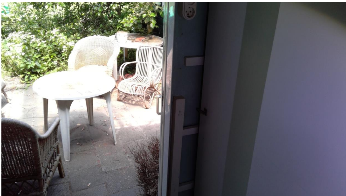
Foto F05 Plaatmateriaal type 1 Binnenzijde woning
