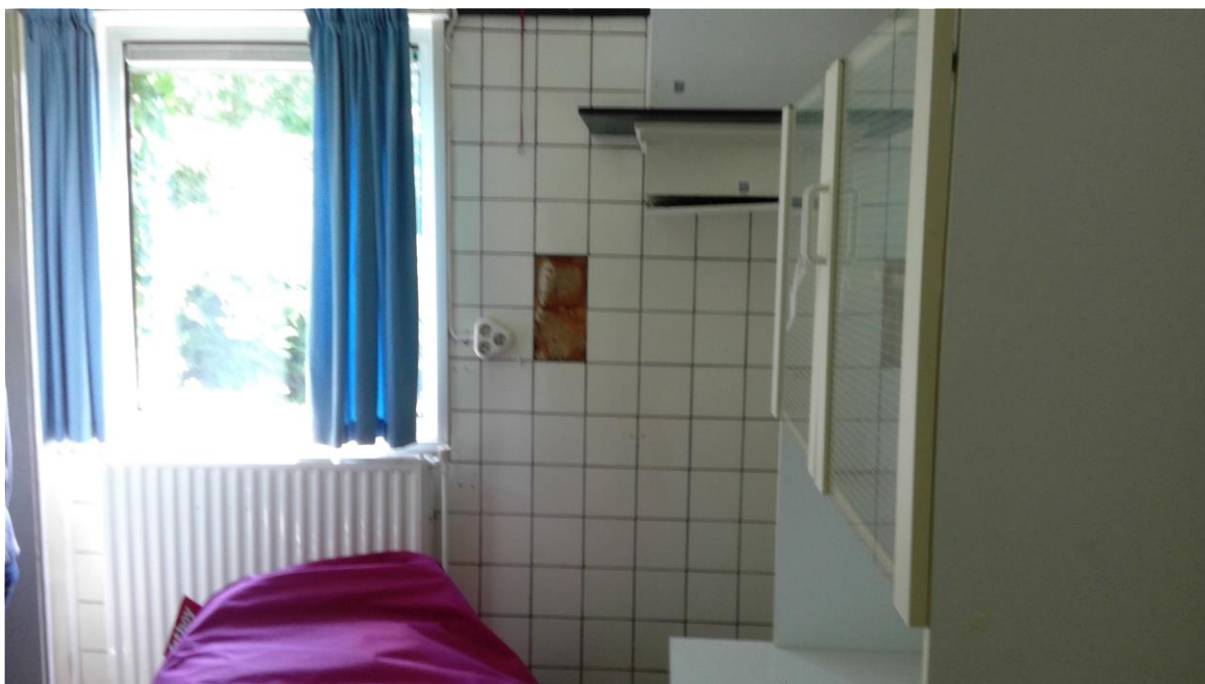
Foto F11 Plaatmateriaal type 1 Binnenzijde woning
