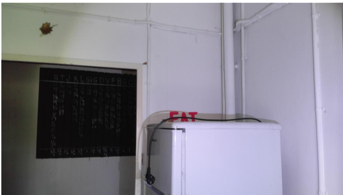
Foto F08 Plaatmateriaal type 1 Binnenzijde woning
