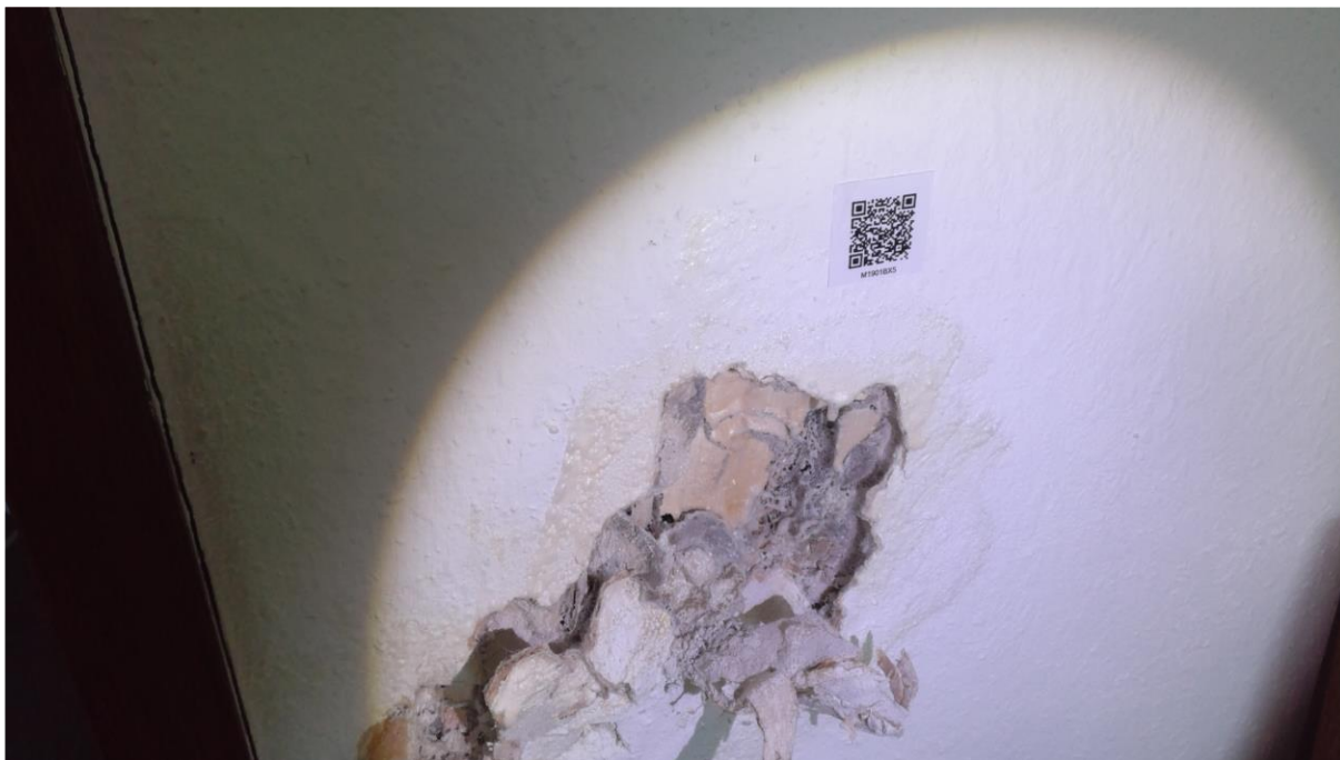
Foto F01 Plaatmateriaal type 1 Binnenzijde woning
