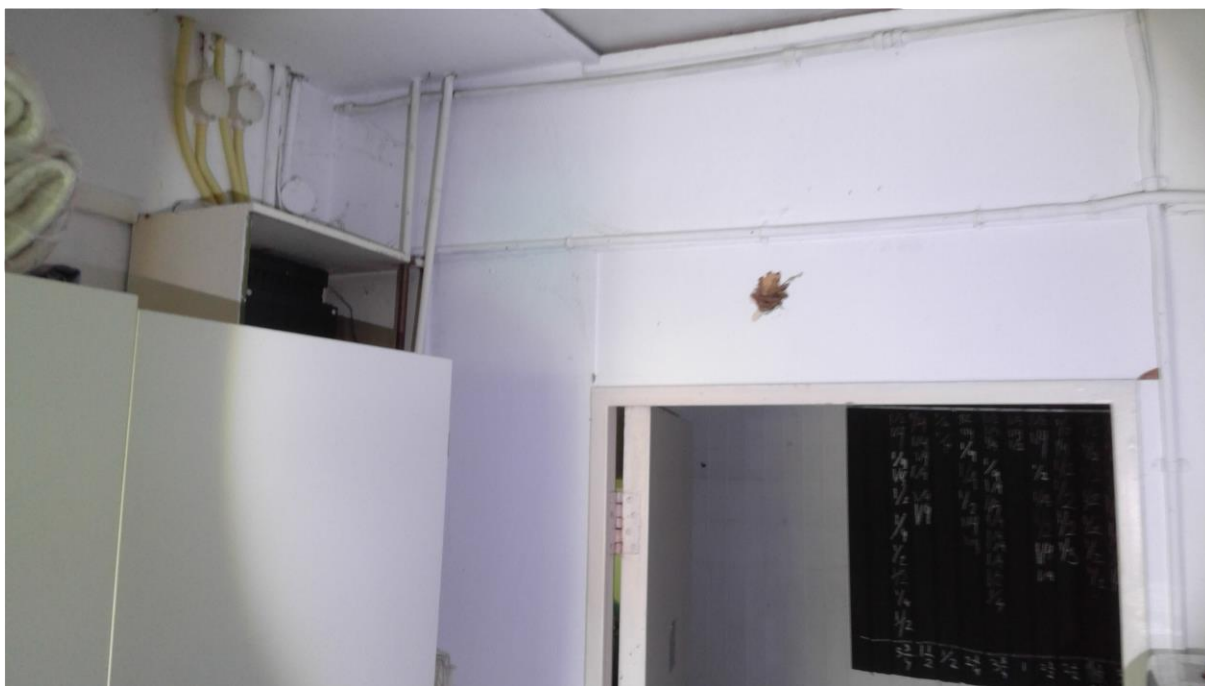
Foto F09 Plaatmateriaal type 1 Binnenzijde woning
