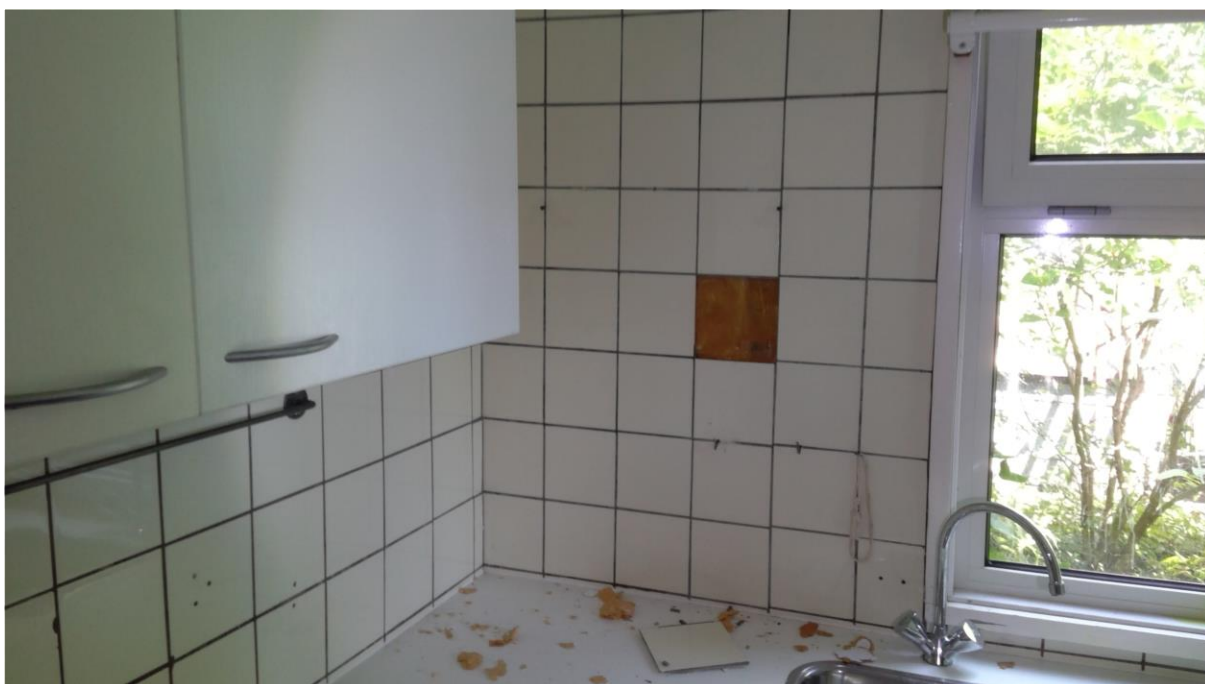
Foto F12 Plaatmateriaal type 1 Binnenzijde woning
