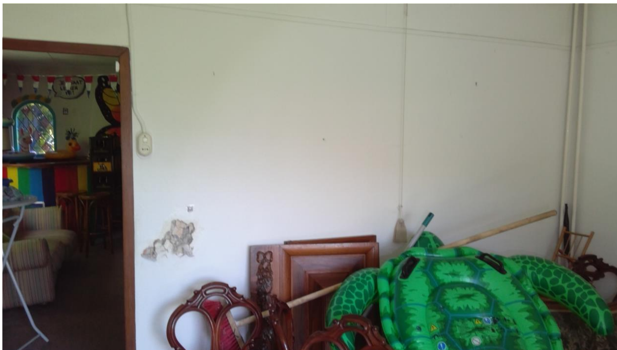
Foto F03 Plaatmateriaal type 1 Binnenzijde woning
