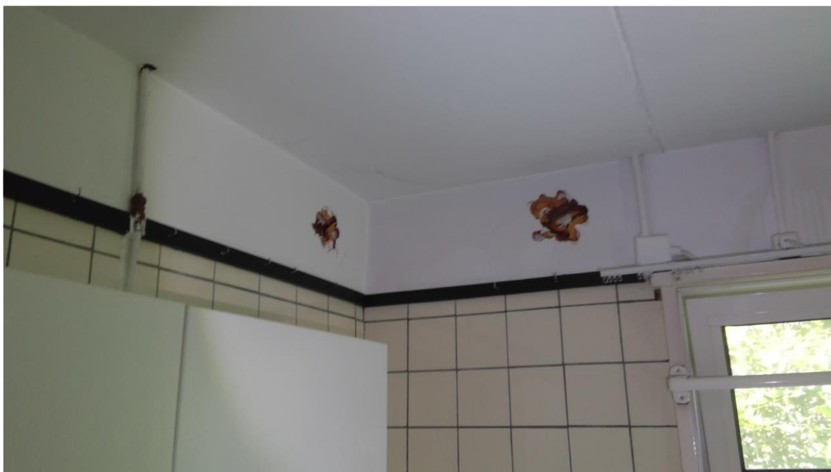
Foto F13 Plaatmateriaal type 1 Binnenzijde woning
