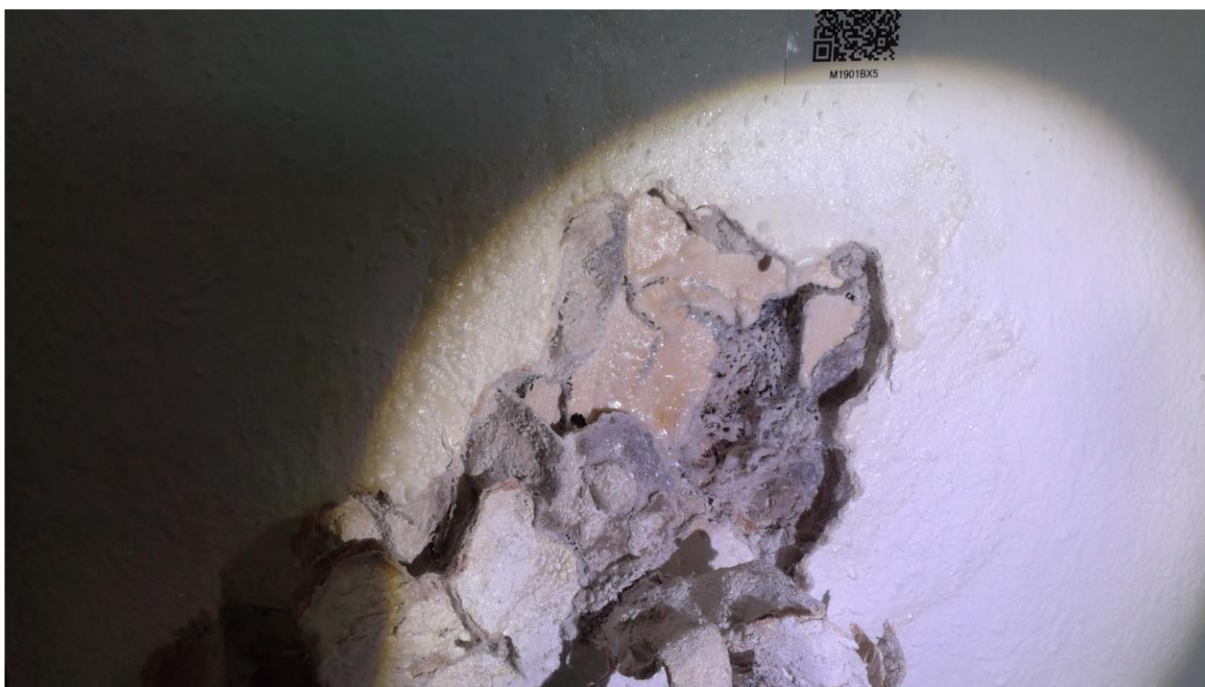
Foto F02 Plaatmateriaal type 1 Binnenzijde woning
