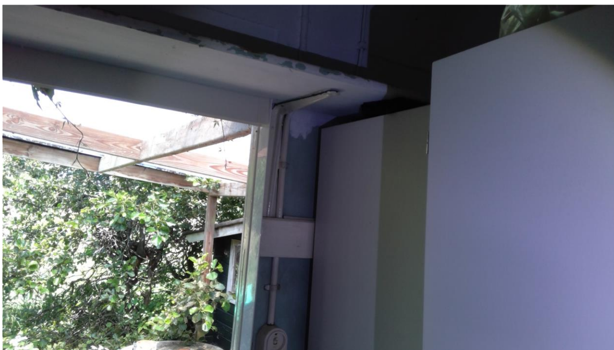
Foto F06 Plaatmateriaal type 1 Binnenzijde woning
