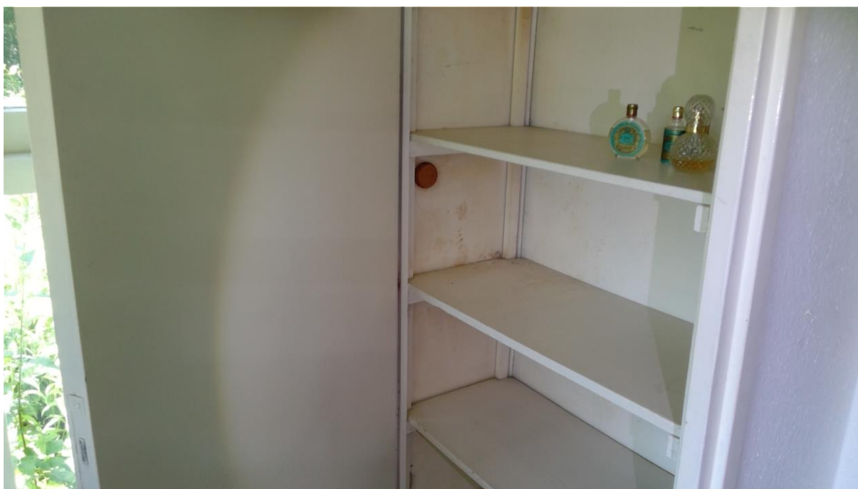
Foto F04 Plaatmateriaal type 1 Binnenzijde woning
