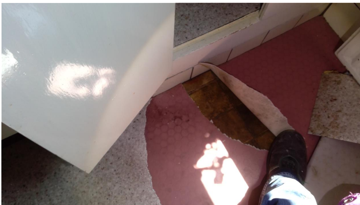
Foto F30 Lijmlaag van vinyltegels Keuken
