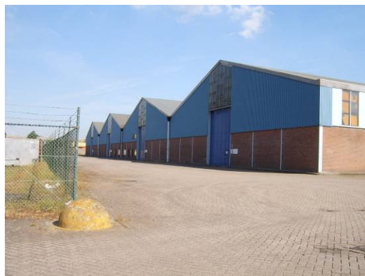
Figuur 7: voorbeeld van bebouwing op industrieterrein
