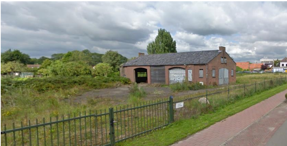
Figuur 4 foto perceel Burgemeester de Zeeuwstraat 195a (zuidzijde gevel bedrijfsgebouw)
