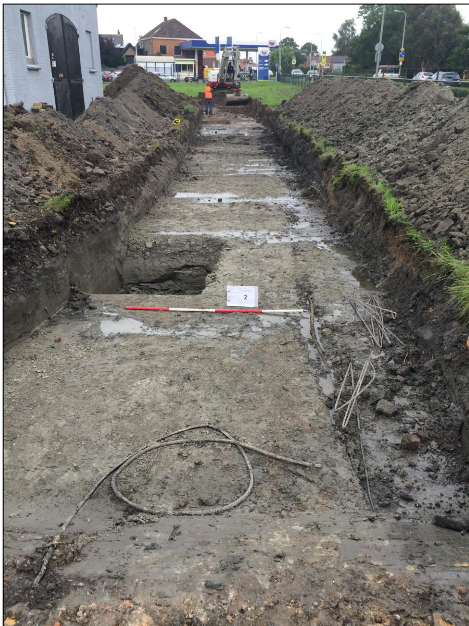
Figuur 9. Het vlak van werkput 1, opname richting het noorden.
