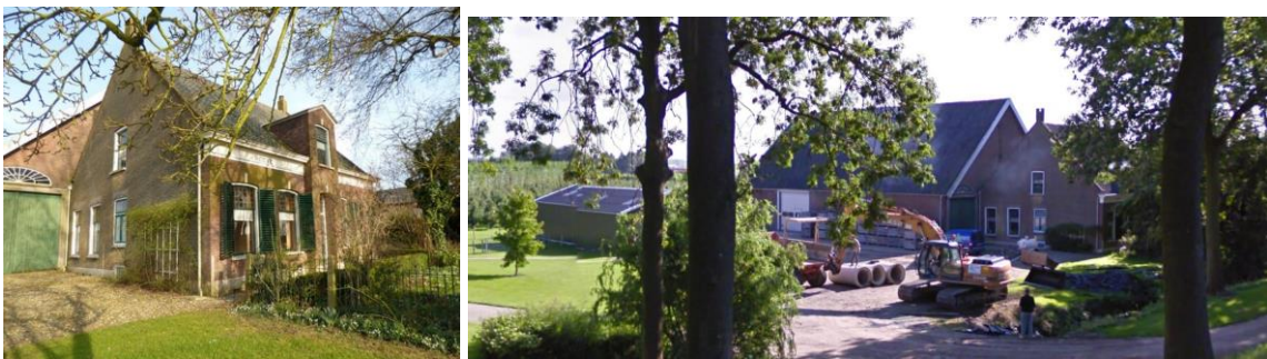
Figuur 2.2 foto's bestaande bebouwing
