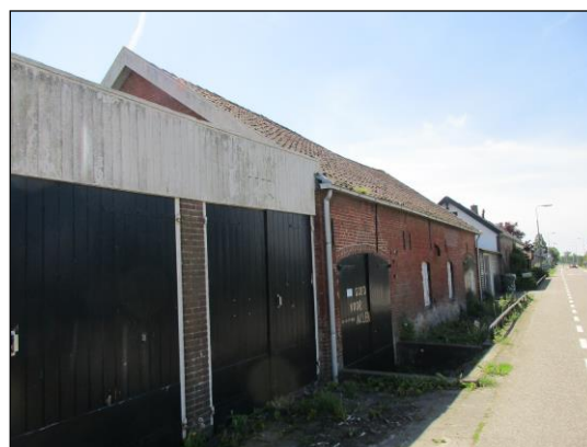
Foto 4: Voorzijde van de bebouwing in het plangebied
