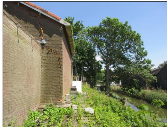
Foto 2: De achterzijde van de bebouwing in het plangebied
