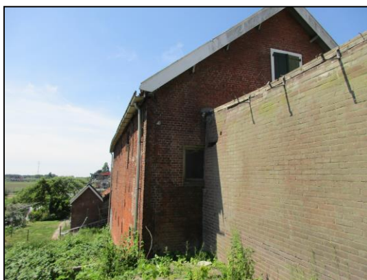
Foto 3: De achterzijde van de bebouwing in het Plangebied
