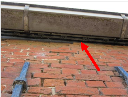
Foto 5: Openingen achter dakgoot
