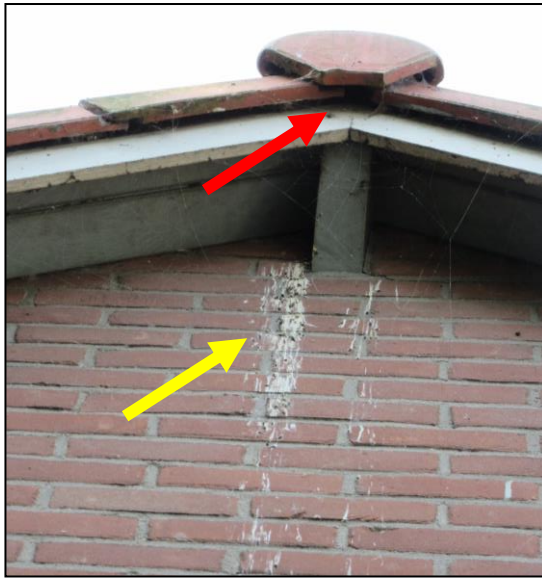
Foto 9: Geschikte ruimte onder dakpannen in nok voor de Gierzwaluw (rode pijl) en krijtstrepen in nok (gele pijl)
