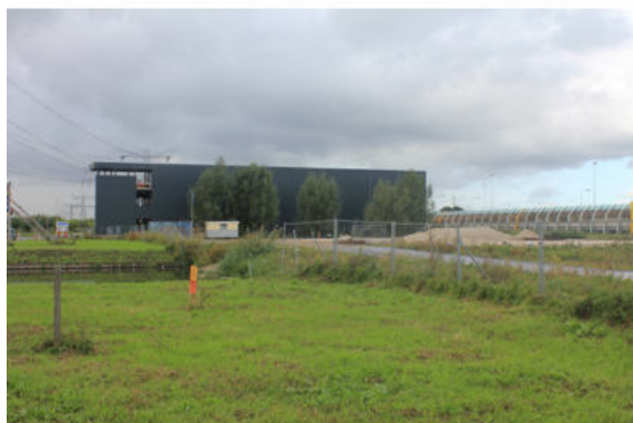
In aanbouw zijnde bedrijf ten westen van planlocatie.
