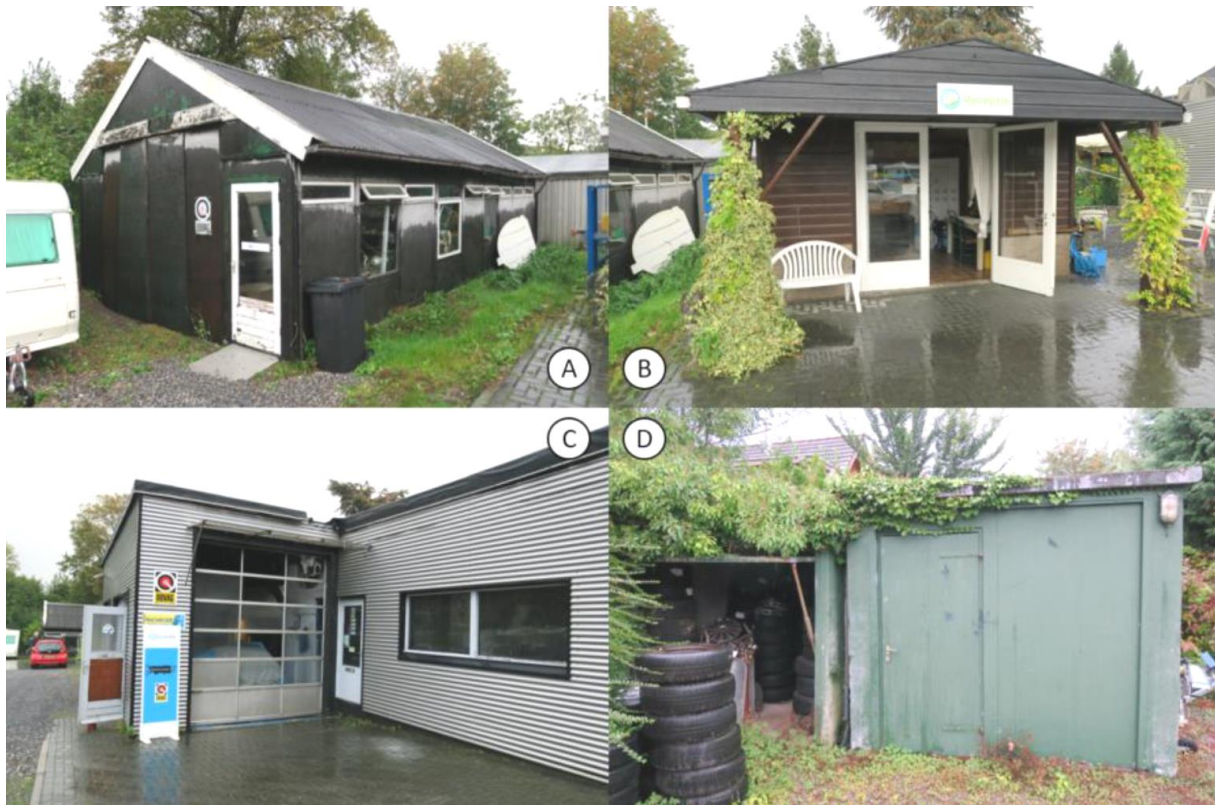
Afbeelding 3: Aanwezige bebouwing: schuur (A), receptiegebouwtje (B), garage (C), garageboxen (D)
