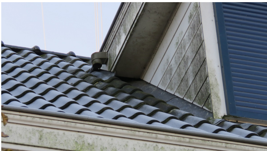
Afbeelding 4: In de hoek onder de dakrand van de dakkapel bestaat potentie voor nestplaatsen van de huismus.
