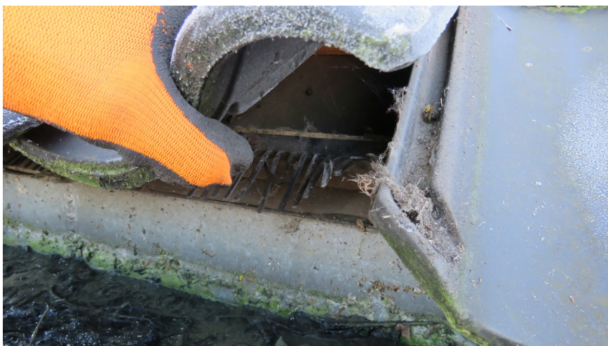
Afbeelding 5: Ter plaatse van de dakgoot is vogelschroot aangebracht onder de dakpannen, aanwezigheid van huismussennesten zijn op deze locatie niet aannemelijk.
