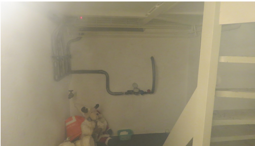
Afbeelding 7: De kelderruimtes zijn alleen vanuit de woonruimtes toegankelijk, deze waren schoon en in gebruik als opslag door de bewoners.
