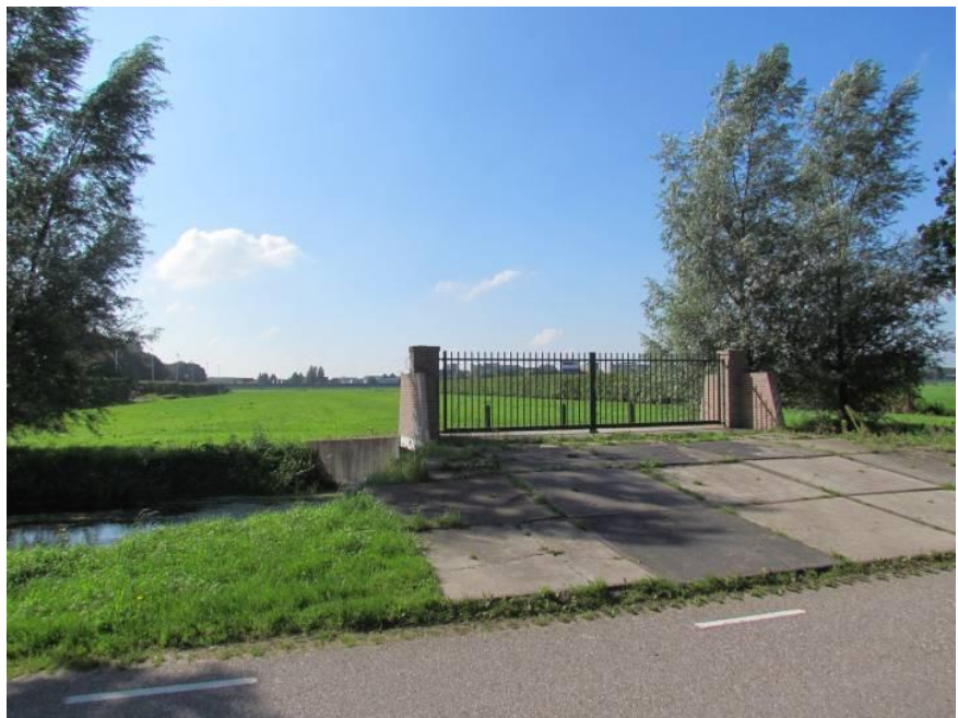
Gebruik maken van bestaande dam als terreintoegang.
