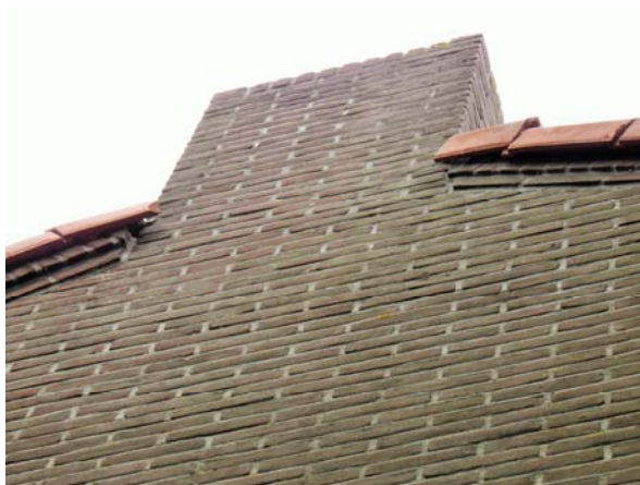
Figuur 9. Overstekende dakpannen met een klein gat, zoals linksboven, geven vleermuizen al genoeg ruimte om tussen te kruipen.
