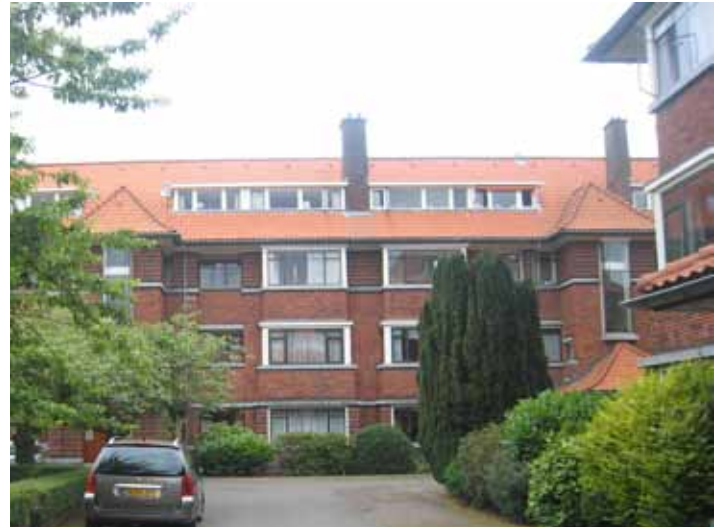
Duidelijke horizontale belijning met verticale accenten op een massa van 3 bouwlagen met kap.
