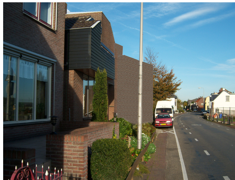
Massa in oostelijke richting langs Baanhoek
