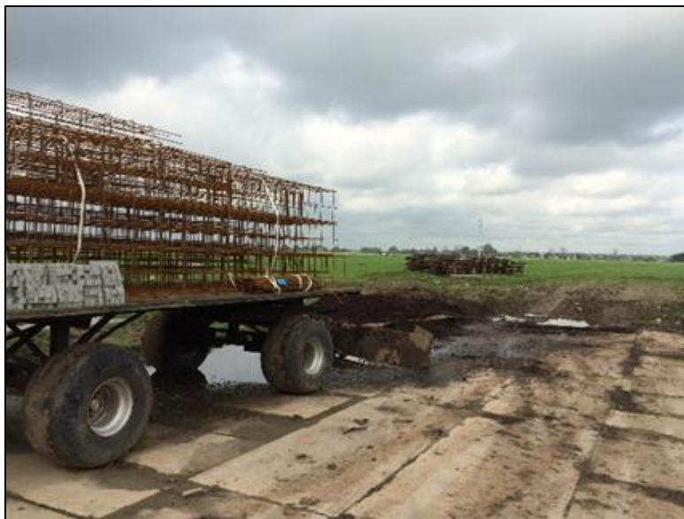
Afbeelding: er wordt gewerkt aan de realisatie van de reeds vergunde uitbreiding van de machineberging en opslagruimte.
