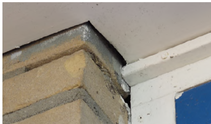
De kieren tussen de bakstenen gevel en het houten boeiboord bieden potentie voor vleermuizen
