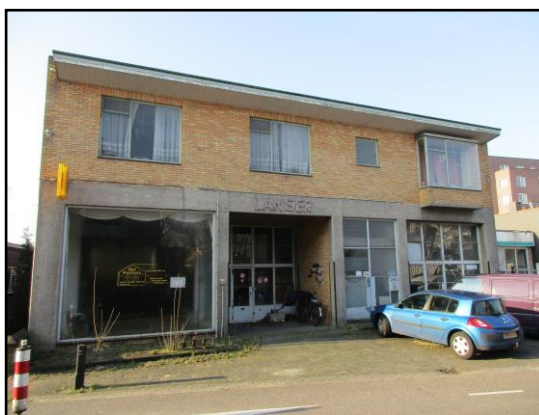
Foto 3: Bedrijfspannd met bovenwoning
