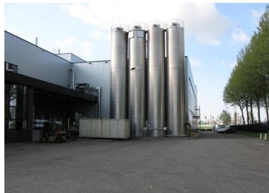
Rechts van de silo's is aanvankelijk geplande schoorsteen.
