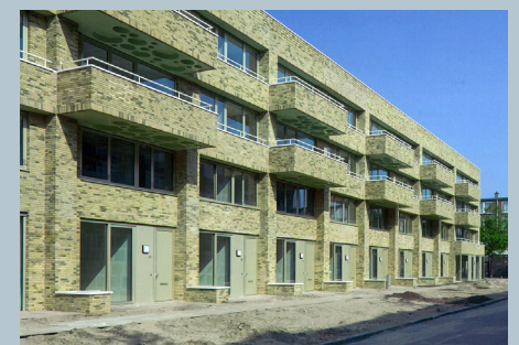
Veel plastic in de gevels door bijvoorbeeld in- en uitstekende raamopeningen en balkons.
