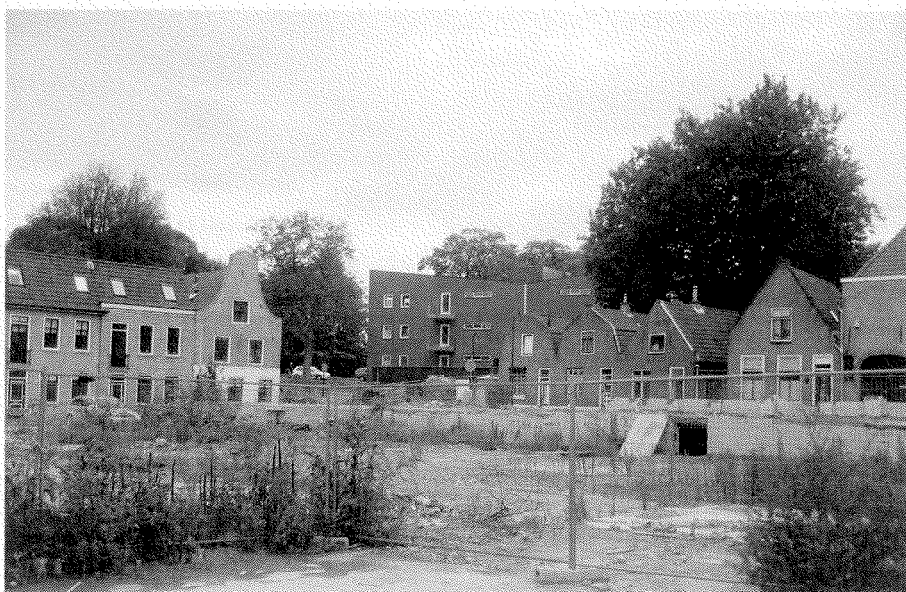
Figuur 1. Huidige situatie Hooijkaas terrein met zicht op de Molenstraat (links achter) en de Korte Dijk (rechts achter). Rechts op de foto binnen de hekken de restanten van een kelder.
